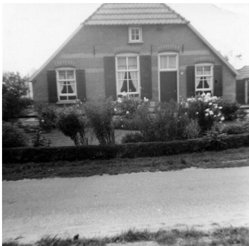
Boerderij "De Floor" aan de Slootsdijk met links de slaapkamer waar het gat in de vloer zat.
