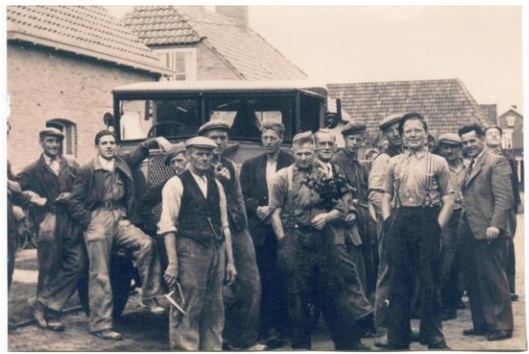
Foto met vrachtwagen bij de bouw van de boterfabriek aan de Wildenborchseweg.
