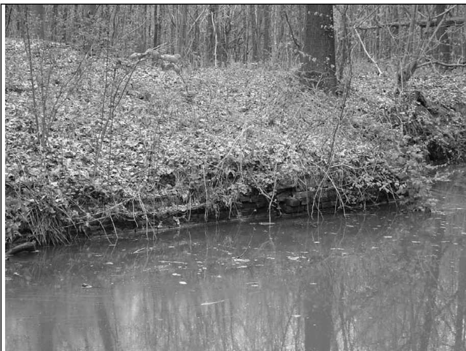
Nauwelijks zichtbare restanten van de spoorbrug over de Baakse Beek in de Meene
