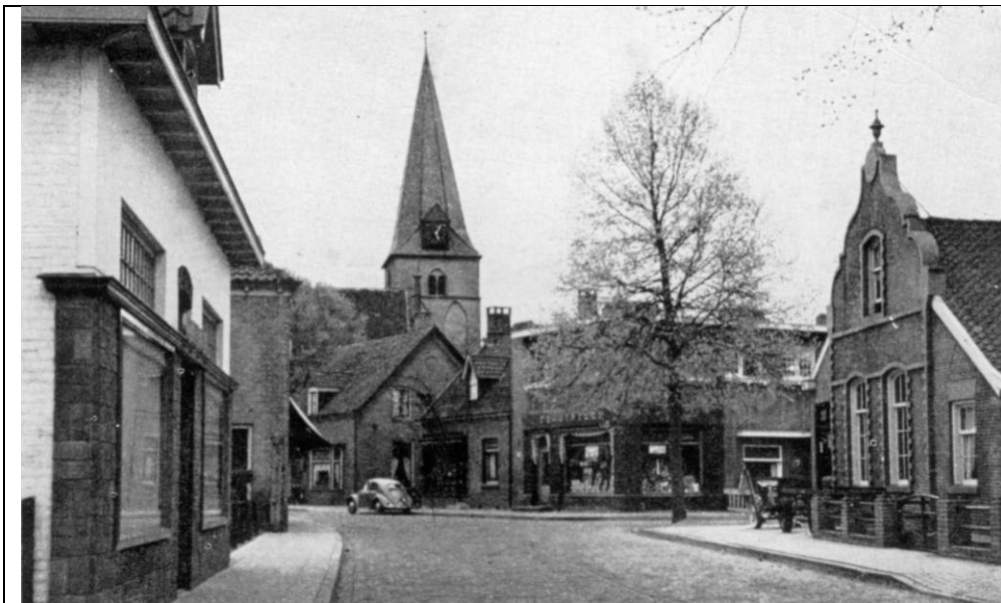
Foto van de Dorpsstraat kort na de oorlog. Rechts op de voorgrond 'de Kluntjespot', dat werd gebouwd nadat de brouwerij van Gotink in 1833 werd afgebroken. De Kluntjespot zelf viel in 1950 ten prooi aan de slopershamer
