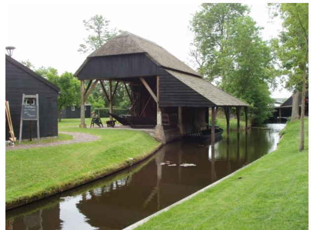
Over het water gebouwde kapschuur
