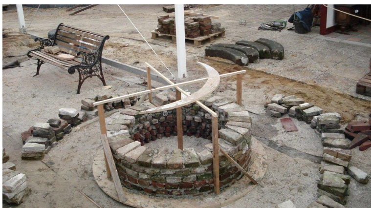
De waterput in aanbouw
