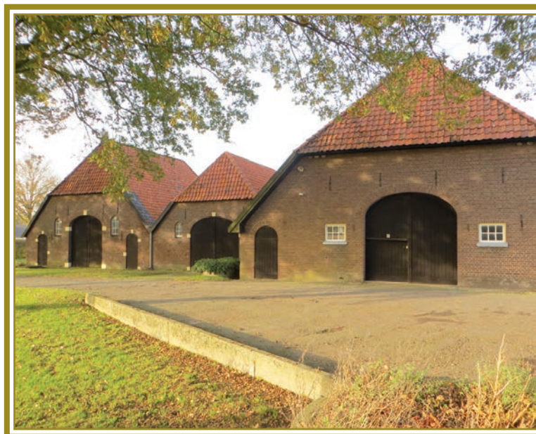
Achterzijde 'De Geck', eigen foto 2020
