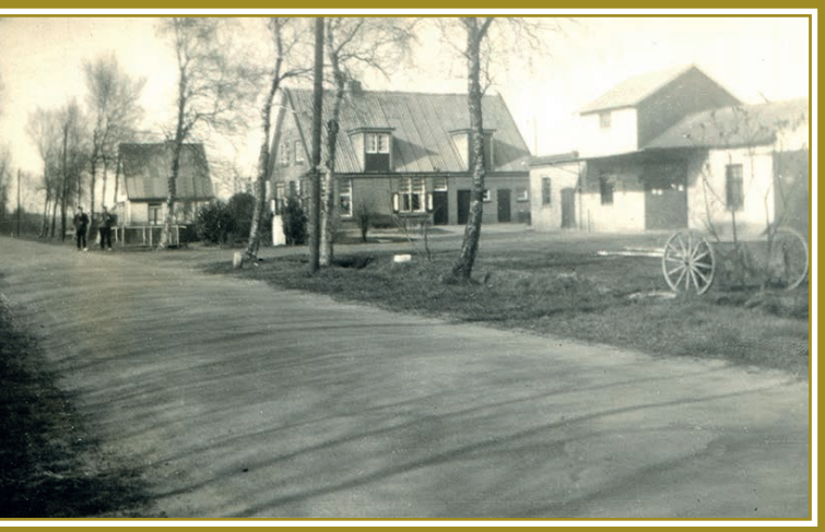
Het filiaal in de Heurne, gezien vanuit de richting van de Tolhut. Rechts de maalderij, dan het woonhuis met winkel. Iets verder zien we het woonhuis/café behorend bij de smederij. De eigenlijke smederij is niet zichtbaar en bevindt zich achter het huis. Tegenwoordig is het nog bestaande witte gebouw van de smederij nog enigszins te herkennen aan de karakteristieke ramen. Mogelijk dateert deze foto uit 1930 of iets later. (collectie familie B. Toevank)
